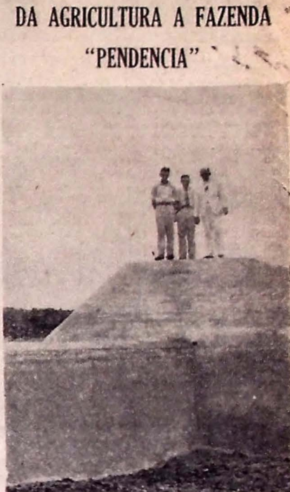
O Secretário da Agricultura Dr. Américo Maia em companhia do administrador da Fazenda Pendência fiscaliza o acabamento do sangradouro do açude vilão construído naquela Fazenda.
