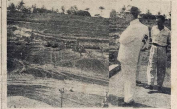
O clichê acima fixa aspectos tomados por ocasião da visita do governador José Americo às obras de Mares, sendo-se a seguir, uma turma de operários e algumas das modernas máquinas track-truck. O governador José Americo, quando examina o andamento dos trabalhos sob a orientação do engenheiro Quiro
