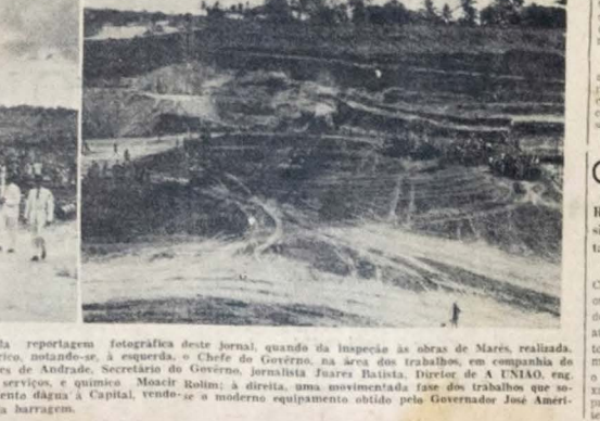
Dois vistas colhidas pela reportagem fotográfica deste jornal, quando da inspeção às obras de Mare, realizadas, ontem, pelo Governador José Américo, notando-se, à esquerda, o Chefe do Governo, na área dos trabalhos, em companhia do prefeito Plínio Lemus, escritor Lopes de Andrade, Secretário do Governo, jornalista Juarez Batista, Diretor de A CIAO, eng. Edvaldo Otero, encarregado dos serviços, e químico Moacir Rolim; à direita, uma movimentada fase dos trabalhos que se desenvolverá no problema de abastecimento da Capital, vendo-se o moderno equipamento obtido pelo Governador José Américo para o mês breve fechamento da barragem.
