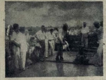
A PRIMEIRA PLACA DE CONCRETO DA ESTRADA JOÃO PESSOA-CAMPINA GRANDE — Realizou-se, ontem pela manhã, com a presença de Governador José Américo e altas autoridades, o lançamento da primeira placa de concreto na rodovia João Pessoa-Campina Grande, de que se trata fragmento a "A", setoria. Vi-se o Chefe do Executivo no momento em que observava o trabalho dos modernos maquinários.
