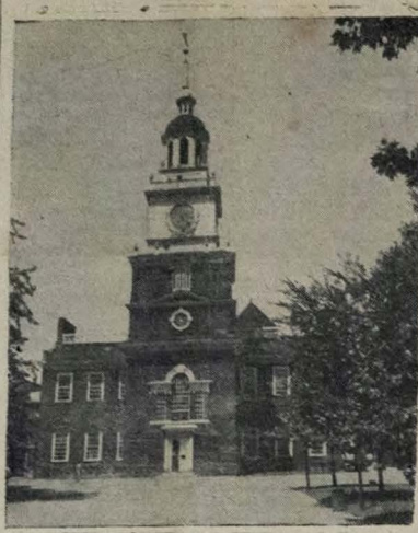
Esta foto mostra a entrada principal da famosa Independence Hall na Filadélfia, Pensilvânia. O grupo de edifícios do Independence Hall consiste do edifício principal, ou central (Câmara do Estado, hoje conhecida como Independence Hall), duas alas ligando, e dois edifícios de dois paramentos chamados East Wing e West Wing (Ala Ocidental e Ala Oriental) e dois edifícios separados de esquina — o Congress Hall e o Old City Hall. A área que circunda a Independence Hall foi transformada em parque nacional em 1948. O Independence Hall foi o local do primeiro do Congresso Continental em 1776 quando a Declaração de Independência foi adotada, e, depois da Revolução, foi o teatro da Convenção de 1787, que formulou a Constituição dos Estados Unidos. (Foto USIS)
