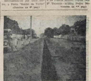
Na Av. Almirante Barroso também se realizam obras do serviço de abastecimento água, nesta fase de ampliação.
