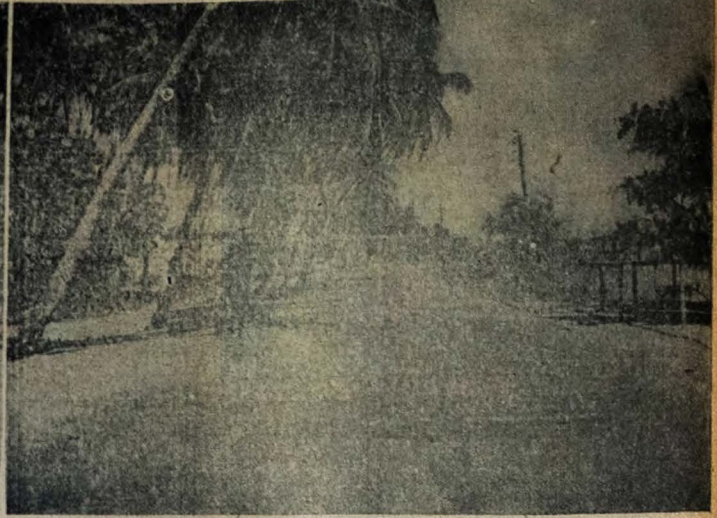
A esquerda: ligação João Pessoa-BR 11 — Aspecto do alargamento e terraplanagem do trecho que liga esta cidade à BR 11. A pavimentação desse trecho tem a vantagem de facilitar o acesso de nossa capital a rodovia nacional que ligará Recife a cidade de Natal. A direita: a pavimentação da praia de Tambaú, iniciada no Governo do Ministro José Américo, não sofreu solução de continuidade por parte da atual administração estadual. A pavimentação dessa bela praia brasileira veio dar um colorido novo ao encanto tropical de sua paisagem. A obra foi toda custeada pelo Governo do Estado, através da Secretaria de Obras Públicas, ficando a sua execução a cargo do D.E.R.
