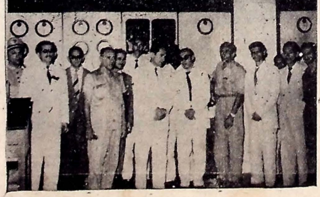
GOVERNADOR VISITOU A CENTRAL ELÉTRICA — Para observar pessoalmente o andamento de trabalhos do DSEEC e combinar providências do maior interesse para o regular funcionamento dos setores encarregados do fornecimento de energia a esta Capital, o Governador Pedro Gondim visitou na manhã de ontem, a Central Elétrica da Ilha do Bispo. No "clube", flagrantemente da visita, vendo-se em primeiro plano, o Governador ladeado do engenheiro Roldrick Leão, diretor do DSEEC, do Secretário Robson Espinola da Viação, do engenheiro Alkmar Coutinho, diretor do Saneamento do Estado, do sr. Gilberto de Souza e de outros funcionários do Departamento visitado. Em baixo, um grupo colhido na sala de reuniões da Central.
