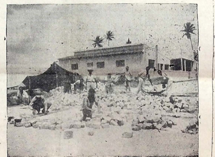
A foto documenta a conclusão dos trabalhos de calçamento da Avenida Pedro I.
