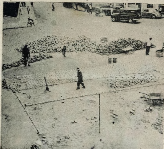
Atendendo a uma solicitação que lhe foi feita pelo delegado especial de trânsito, coronel Passos Filho, o prefeito Damásio Franca determinou o alargamento da área pavimentada situada ao lado da Assembleia Legislativa, na praça Aristides Lobo. A entrega da obra está prevista para os próximos dias.
