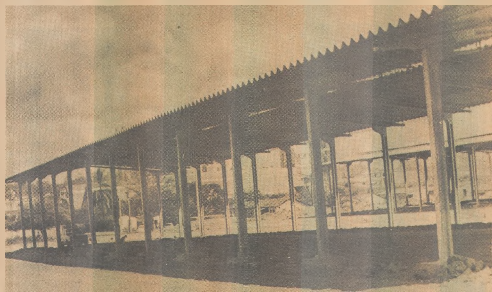
Os trabalhos do Distrito Mecânico. reiniciados pela Prefeitura
