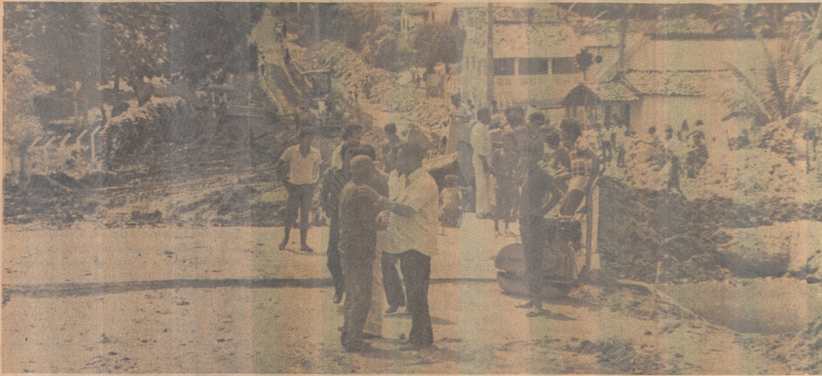
As máquinas já estão concluindo os trabalhos no trecho que ligará os bairros do Varjão e de Jaguaribe
