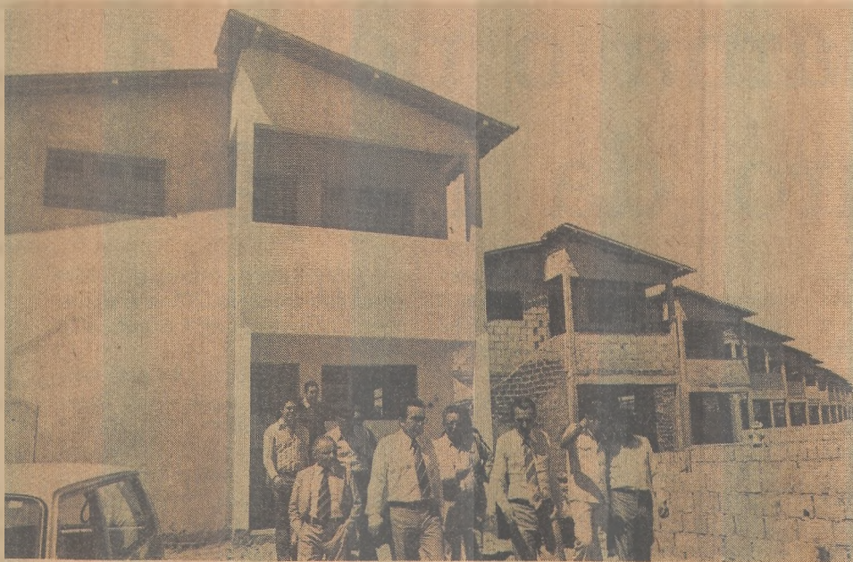
Os novos conjuntos têm suas obras quase concluídas
