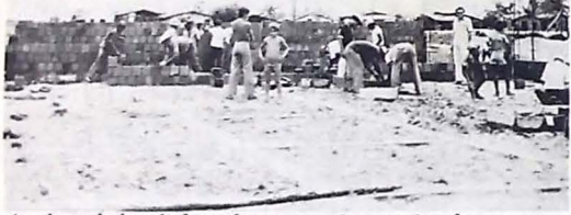
As obras do hospital continuam em ritmo acelerado
