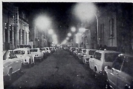
Moderna iluminação na rua Duque de Caxias
