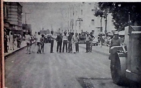
O prefeito e o asfaltamento da Guedes Pereira
