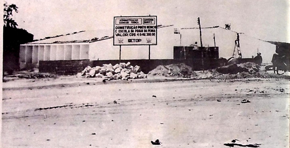
Construção do Posto Médico na praia da Penha
