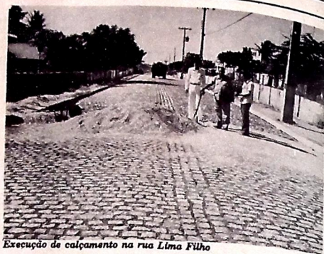
Execução de calçamento na rua Lima Filho
