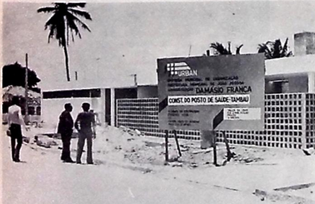
Outra grande obra: construção do Posto de Saúde de Tambau
