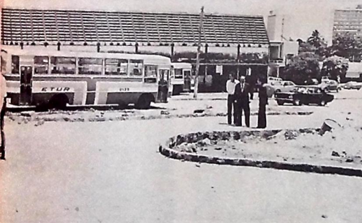
Renovação do Mercado Central
