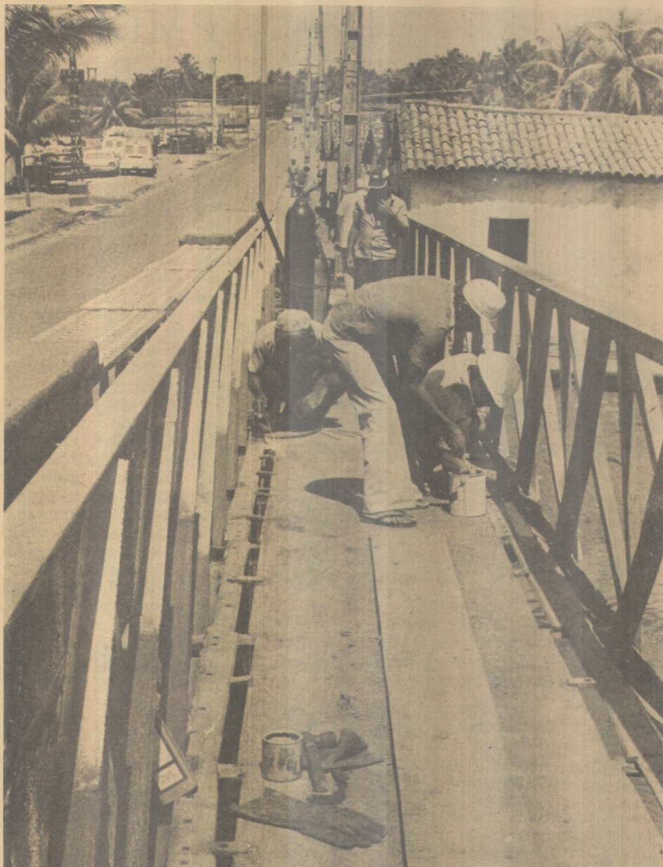
Depois de vários acidentes, alguns deles de consequências graves, a Prefeitura Municipal através da sua Secretaria de Obras, resolveu determinar a seus funcionários que fizessem um reparo na passarela de pedestres que fica ao lado da Ponte sobre o Rio Sanhaú, trecho que liga João Pessoa à cidade de Bayeux. A passarela há dias atrás, e já há algum tempo, tinha o piso sustentado apenas por vigas de madeira e os pedestres para ultrapassá-la tinham que ser exímios equilibristas. Os funcionários colocaram plaquetas de ferro e deram nova pintura à passarela.
