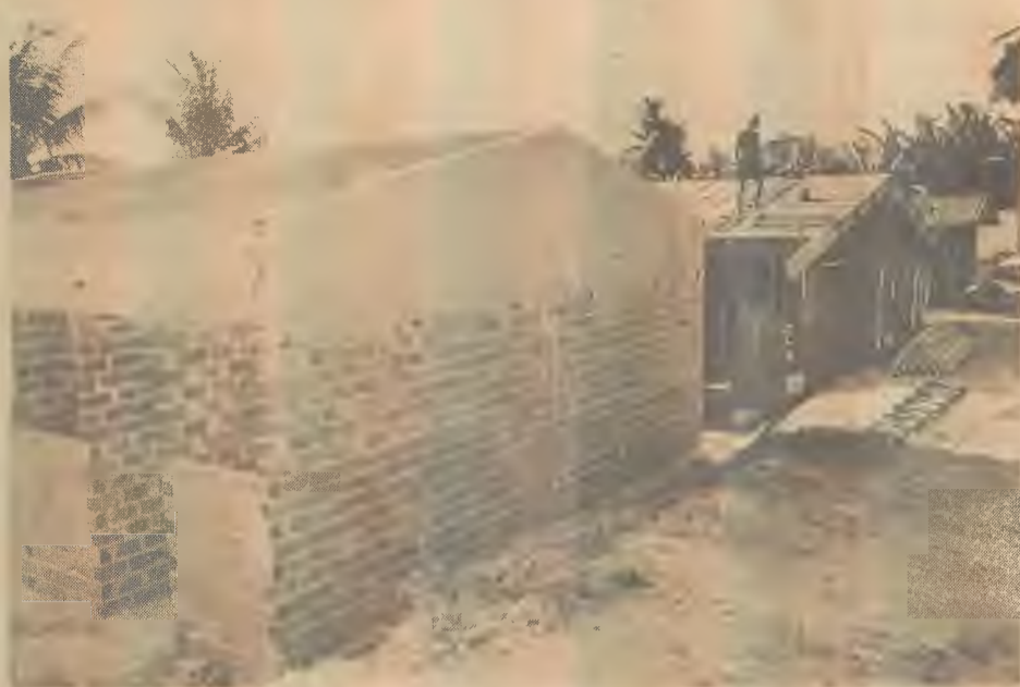
Continuam as obras da nova Casa do Estudante
