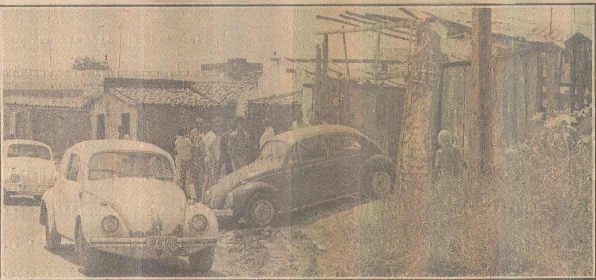
Todos os casebres localizados nas imediações da Estação Rodoviária estão sendo demolidos.
