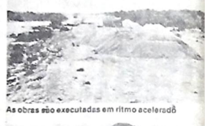
As obras são executadas em ritmo acelerado
