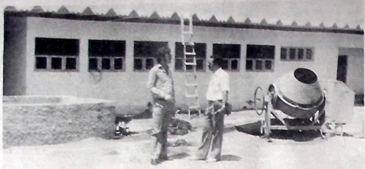
As obras estão adiantadas, mas ainda não está marcada a data de inauguração
