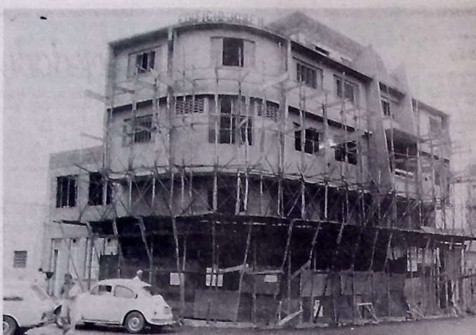
Obras de reforma do novo hotel campinense
