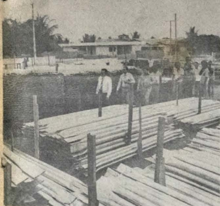
Tarcísio Burty visita as obras do Espaço Cultural
