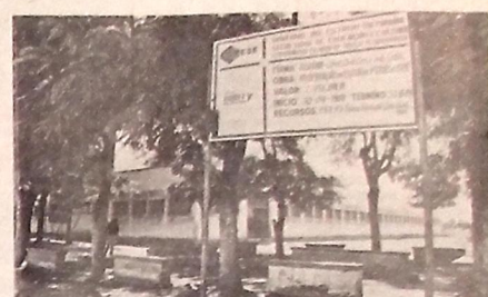
Escola de 1ª grau, na sede do município, em recuperação
