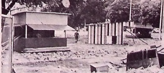
Barracas para venda de fogos já estão sendo instaladas
