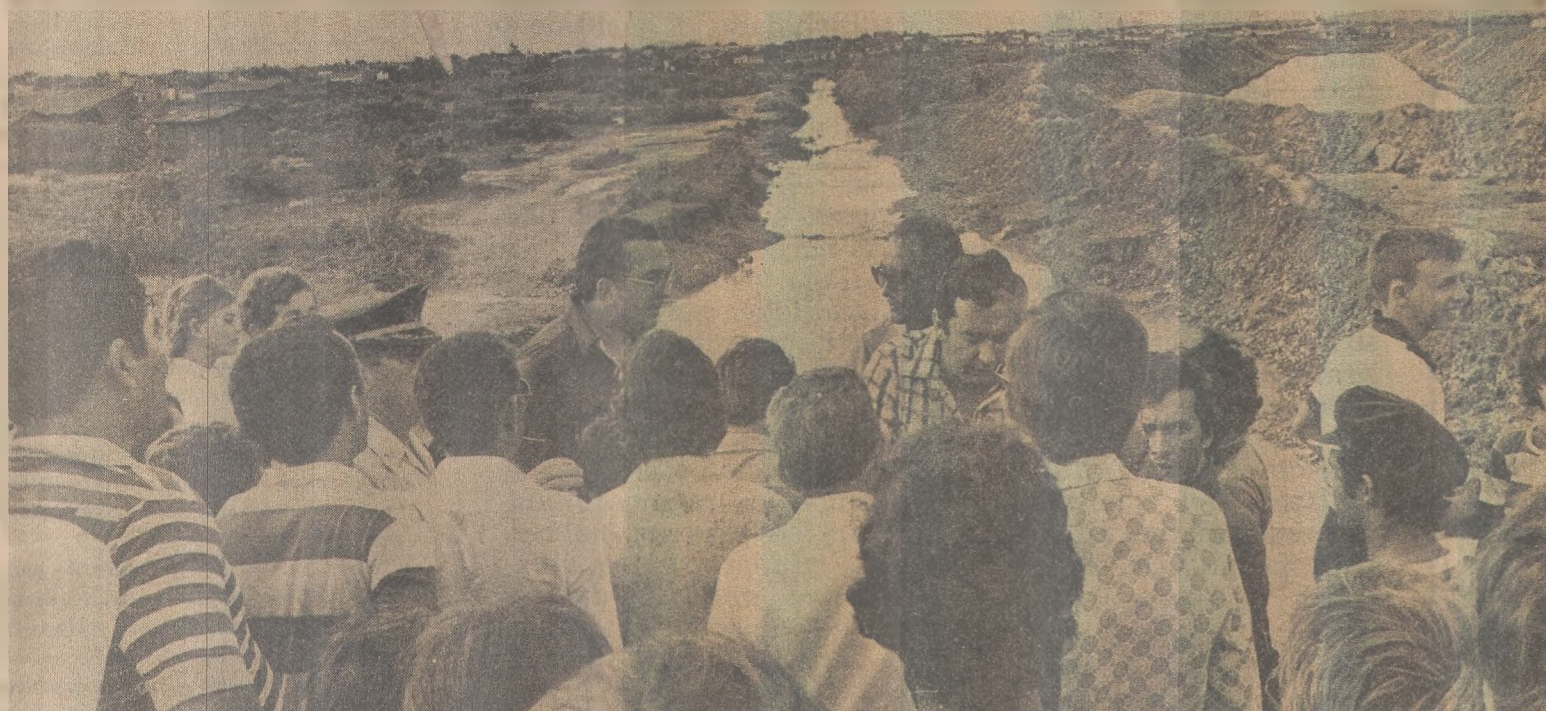
O governador Tarcísio Burity esteve em Sousa visitando as obras de construção do Canal do Estreito
