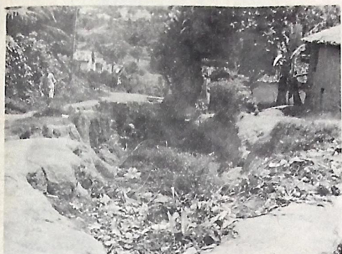
Há um ano este buraco provoca acidentes no bairro do Rangêl
