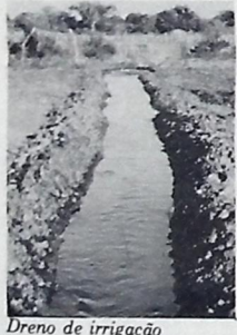
Dreno de irrigação
