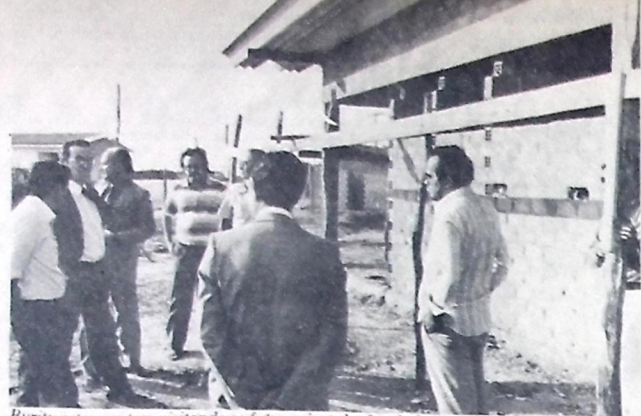
Burty esteve ontem visitando as futuras instalações do Instituto de Polícia Científica
