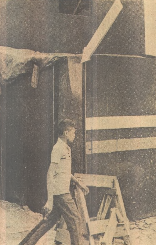
A rua José Lucas de Carvalho, perpendicular à praça 1817, está interditada, não dando acesso aos veículos. A razão da interdição é a construção de novas instalações do Banespa, pela Civilia Engenharia S. A. A nova sede do Banespa está sendo construída na esquina da rua José Lucas de Carvalho com a 1817, o que gerou a interdição de toda a rua com a construção de uma sala de madeira feita para o funcionamento do escritório da construtora, que tem como técnicos responsáveis os engenheiros Emílio Paulo, Edson Fonseca e Gilberto Scafuro. Além de interromper a passagem dos veículos que circulam pela artéria, principalmente os que residem na José Lucas de Carvalho, os transeuntes também foram prejudicados com a interdição da rua, pois foi deixada apenas uma pequena passagem entre a parede da esquina e as madeiras do escritório da construtora Civilia.
