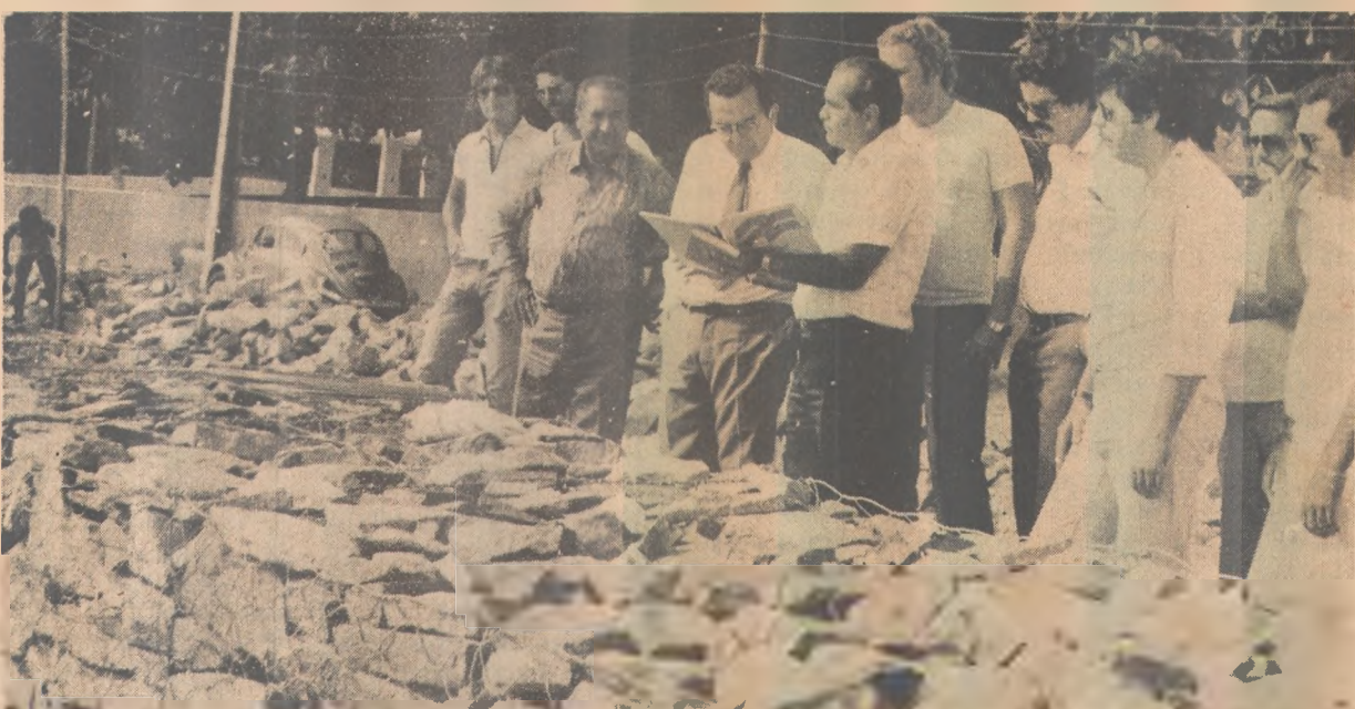
Próximo ao clube de Engenharia, um dos gabões semelhante a um construído na Itália
