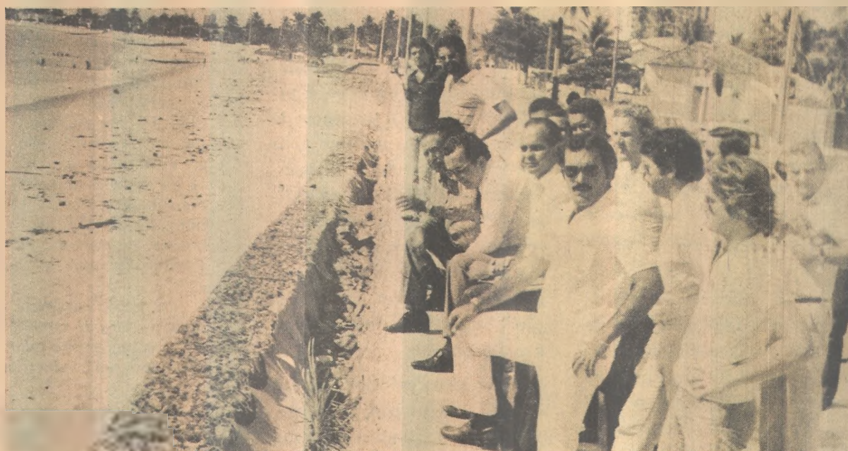
Na João Maurício, o governador inspeciona obras do gabões, que impede o avanço do mar
