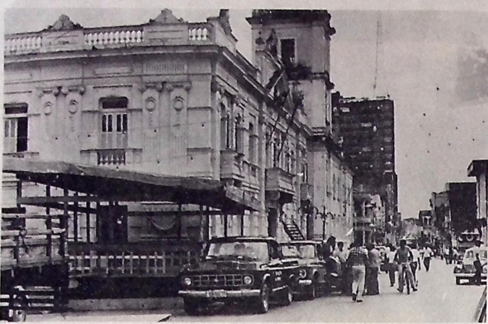
Equipes tomaram as providências no sentido de que a praça receba um grande público
