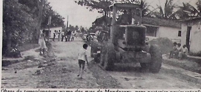
Obras de terraplenagem numa das ruas de Mandacaru, para posterior pavimentação
