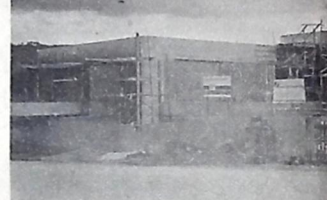
Obras de construção da agência da CEF
