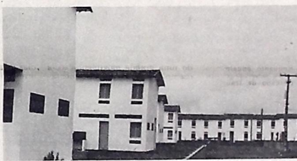
... pronto, faltando o serviço de esgoto para conclusão
