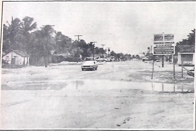
Para agilizar as obras da Rua Moinho, a prefeitura iniciou colocação do meio fio
