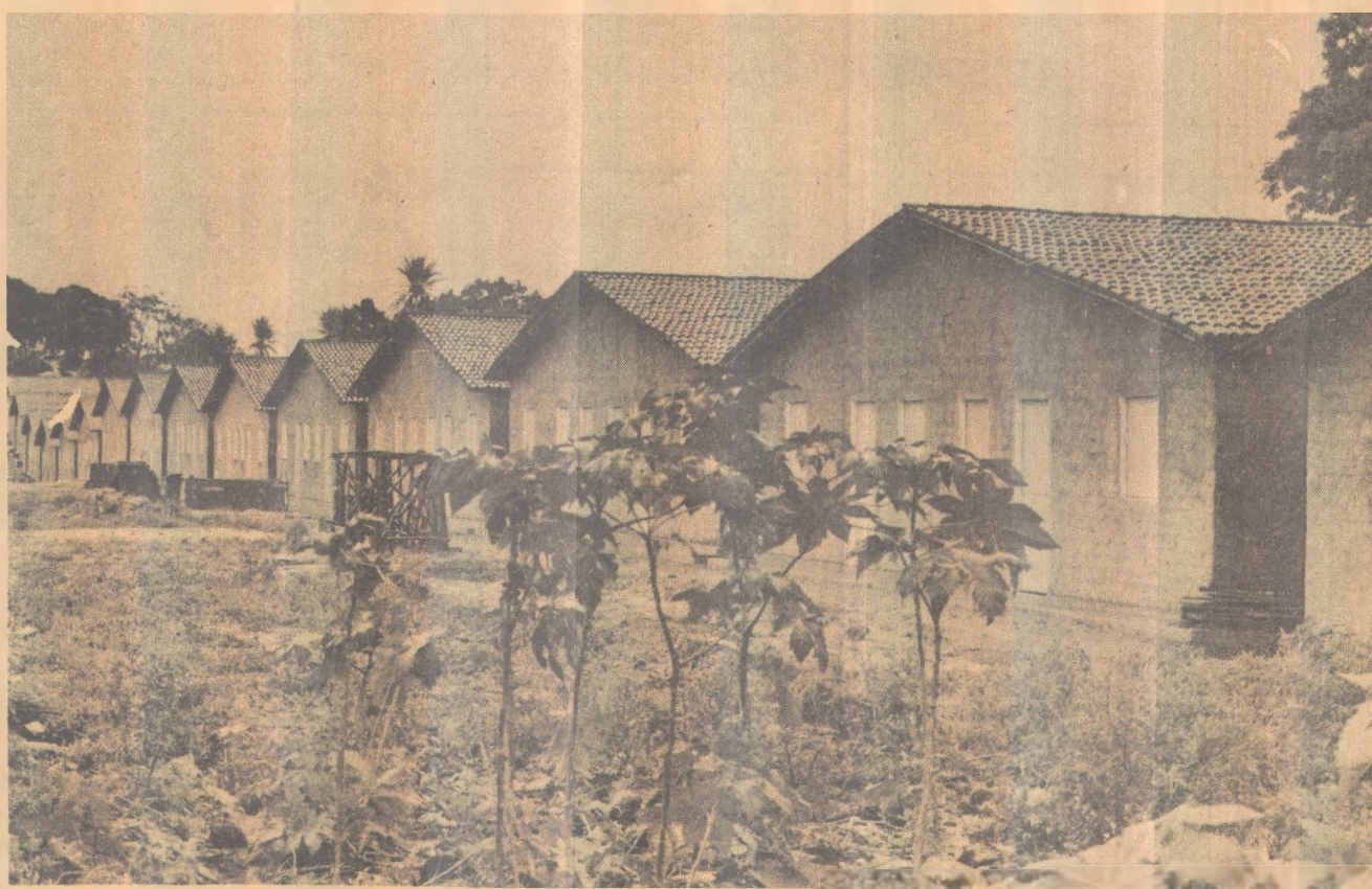
Na agrovila do município de Sapé, o Procanor concluiu 30 casas para trabalhadores
