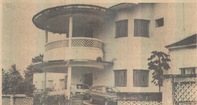
Os maçons viram as obras de recuperação do hospital
