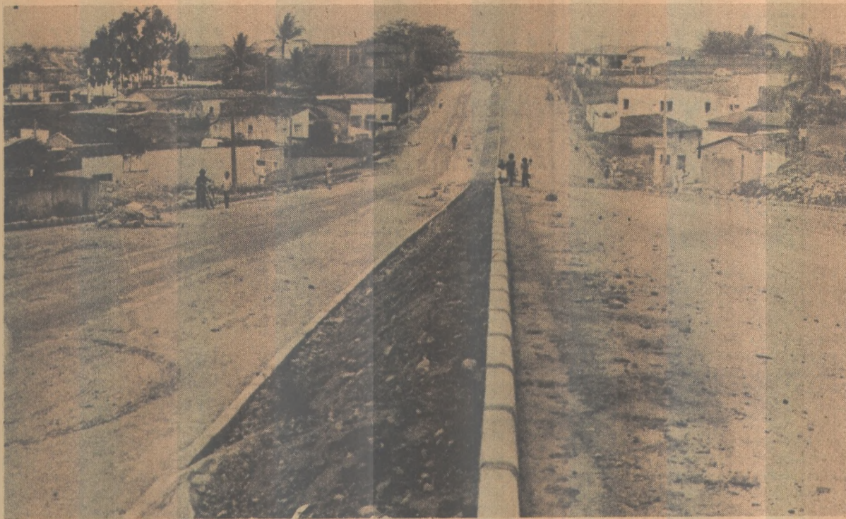
As obras do Projeto Cura prosseguem com implantação de pavimento asfáltico
