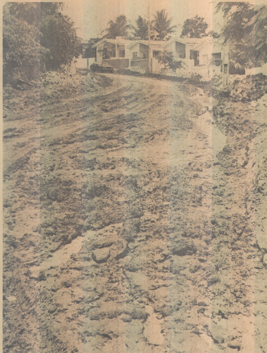
No Conjunto dos Jornalistas, obras em andamento
