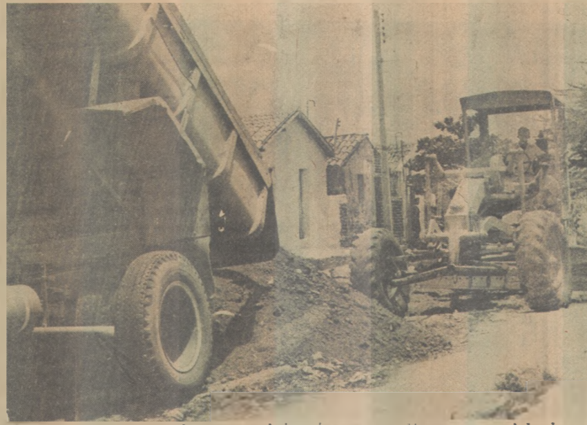
Tratores e caçambas requisitados para limpar a cidade
