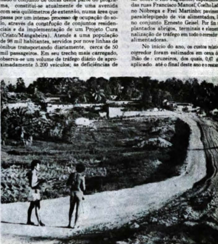
Falta o revestimento em asfalto para a conclusão das obras
