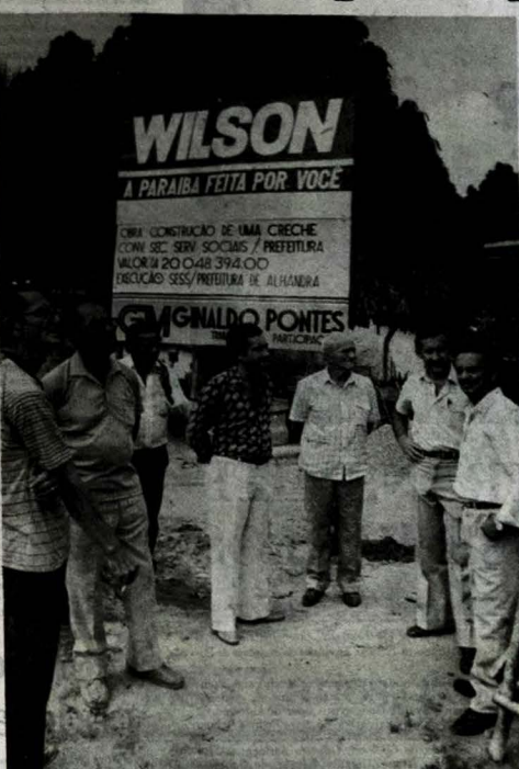
Eitel Santiago visitou o local onde é construída a creche
