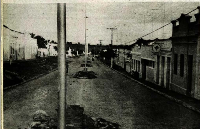
Vista parcial do novo sistema de iluminação e a construção dos bancos destinados ao lazer
