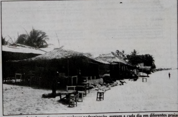
Construções de todos os tipos, sem qualquer padronização, surgem a cada dia em diferentes praias
