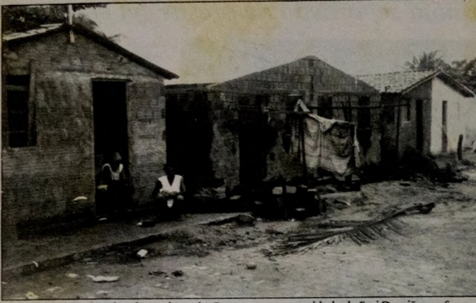
Unidades habitacionais reformadas pelo Governo na comunidade de Frei Damião em Sousa
