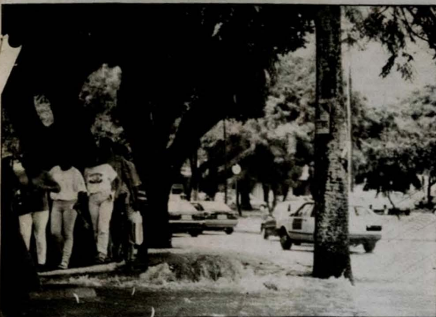
Pela manhã, problemas de sempre na Lagoa, com esgotos estourados
