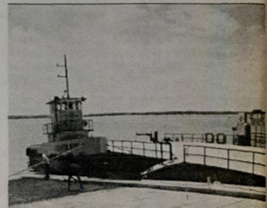
As obras nas rampas foram adiadas em função das chuvas
