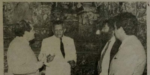
Visitando obras de restauração do Museu Sacro do Estado (outubro de 1986)
